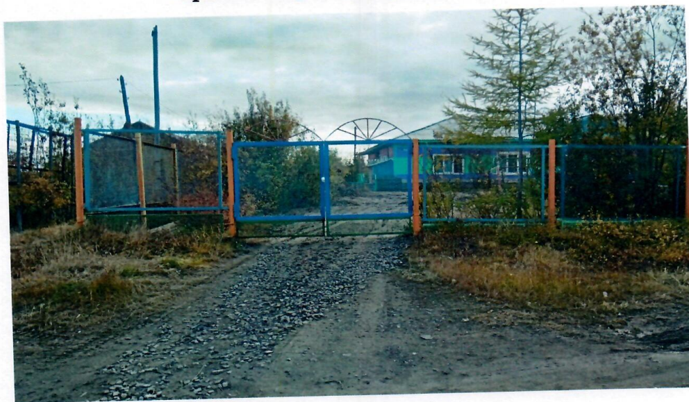
Ворота со стороны центрального входа
